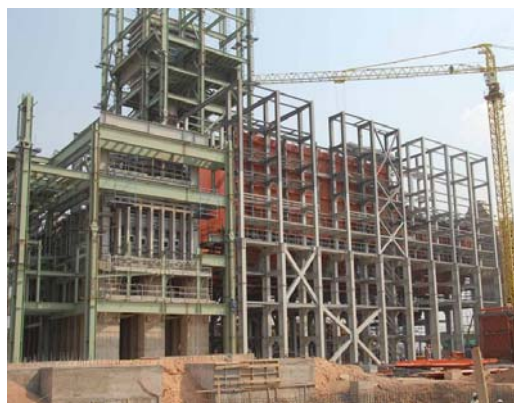
有色冶炼余热锅炉
