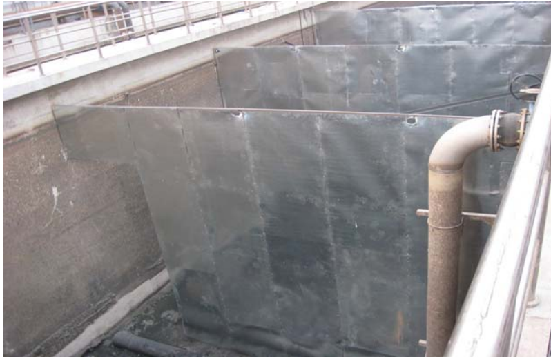
开展大型生产实验，辅助污水厂升级改造
