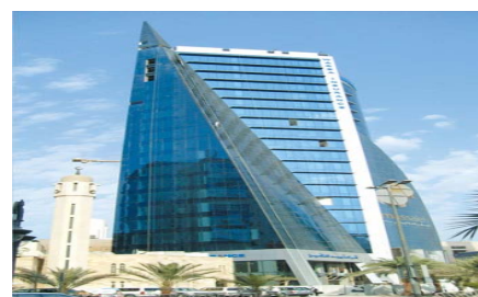
科威特 Warba 保险大楼双玻璃光伏遮阳棚
