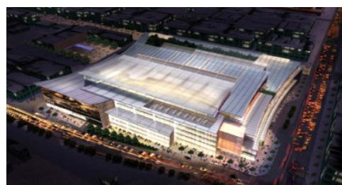
光伏建筑组件应用于沈阳恒隆广场
