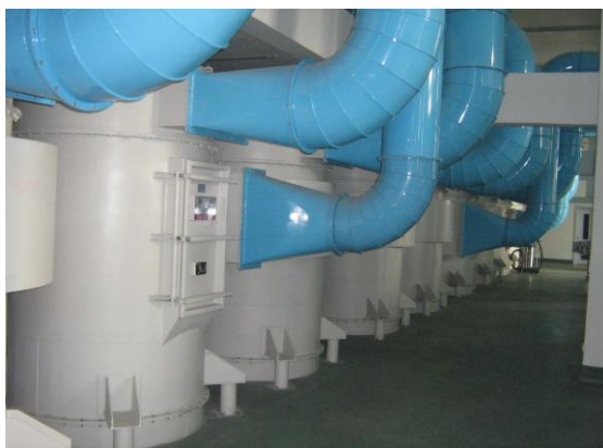
国内最大的精米加工厂袋式除尘器（粮食行业. 中粮集团大连米业）
