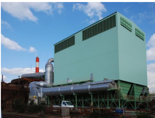
日本大同特殊钢项目袋式除尘器（冶金行业）
