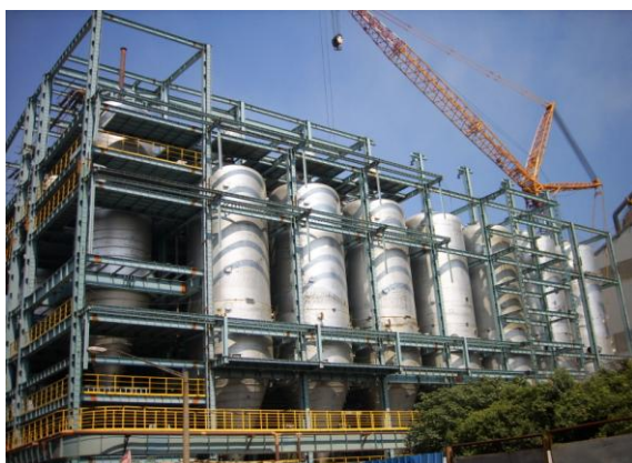
国内最大的 5000m 3 高炉煤气袋式除尘器 (冶金行业. 宝钢)
