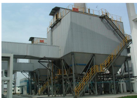
热电站炉长袋脉冲除尘器 (电力行业. 无锡友联)
