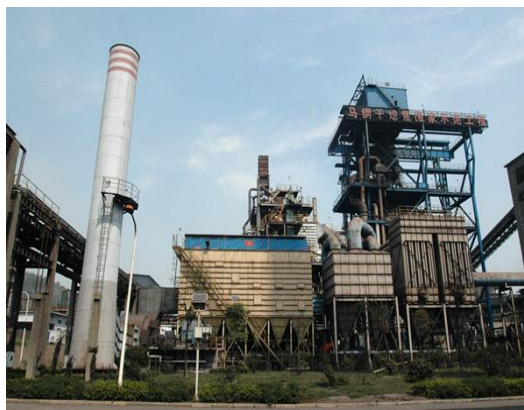
国内最大的 7.63 米焦炉系统袋式除尘器 (冶金行业. 马钢)
