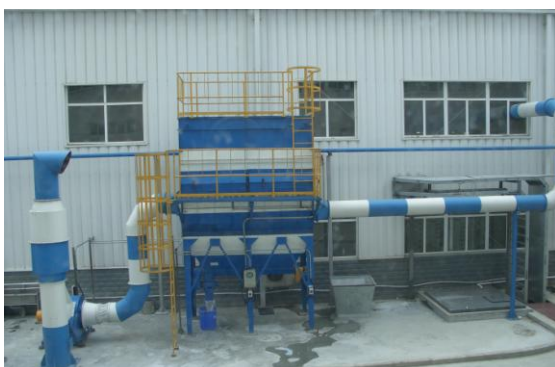
洗衣粉生产袋式除尘器（轻工化学行业. 联合利华）
