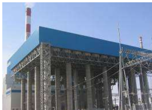
内蒙古达拉特电厂四期 2×600MW 空冷平台钢结构工程
