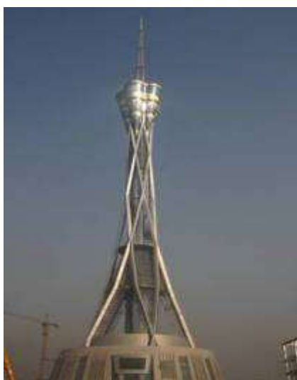
河南广播电视发射塔钢结构工程
