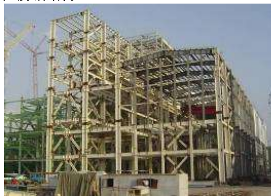
华电国际灵武电厂一期 2×600MW 主厂房钢结构工程
