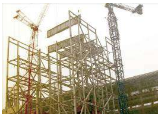
江苏扬州二电厂二期 2×600MW 锅炉钢架工程
