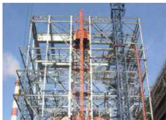
安徽铜陵电厂五期 1×300MW 锅炉钢架工程
