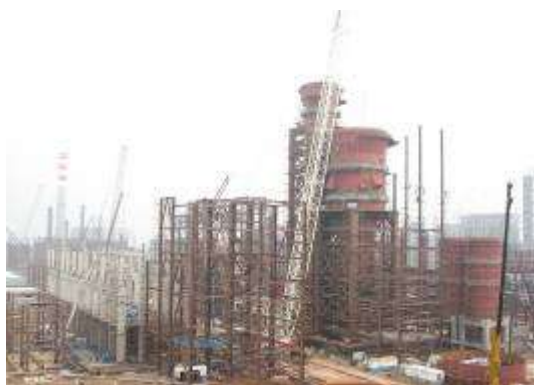
中石化青岛大炼油钢结构工程
