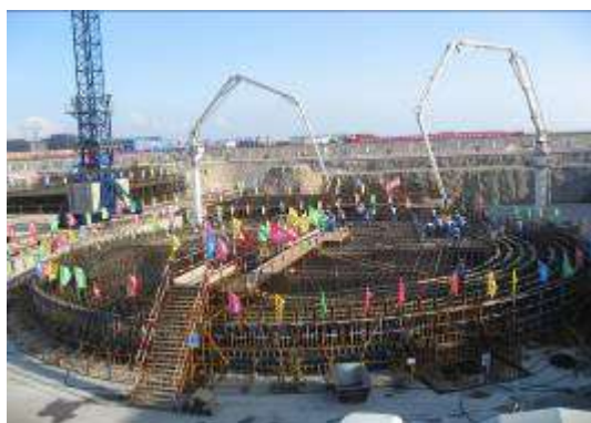
福建宁德一期 AP1000 核电机组 常规岛 BOP 厂房钢结构工程
