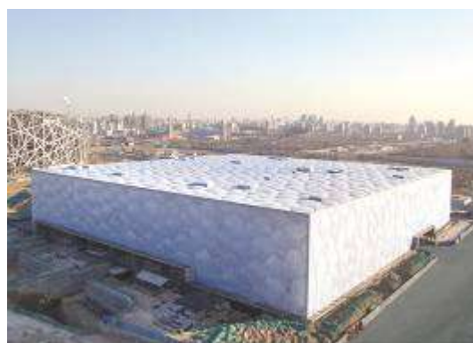
国家游泳中心“水立方”钢结构工程
