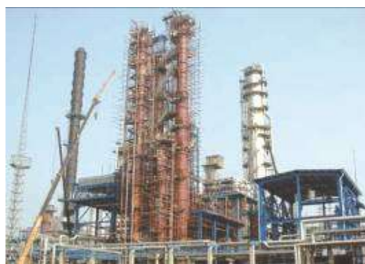
伊朗 SHAZARAK 炼油厂扩建钢结构项目
