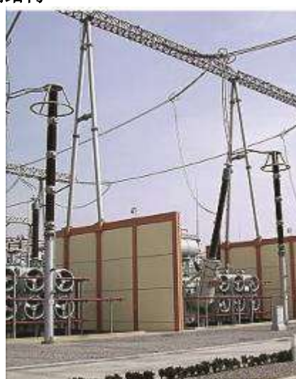
西北电网 750KV 官亭变电站钢结构
