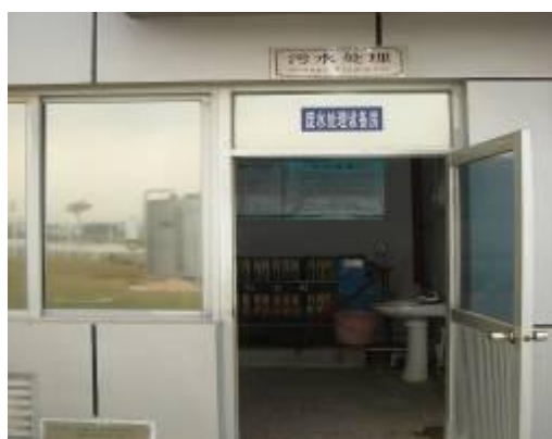
致君制药污水处理及管网系统改造
