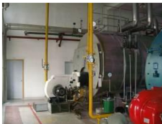
致君制药锅炉油改气项目
