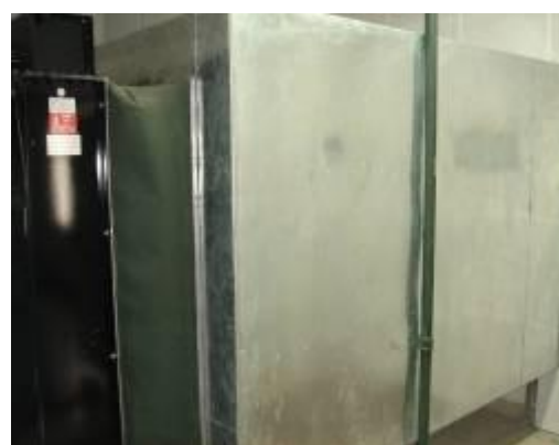
致君制药备用发电机废气噪音处理改造
