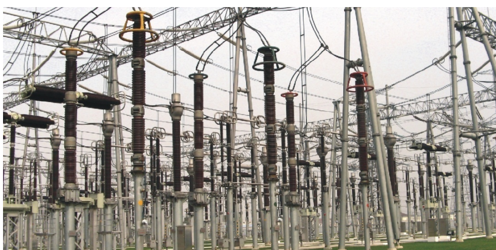
电站使用的棒形支柱瓷绝缘子
