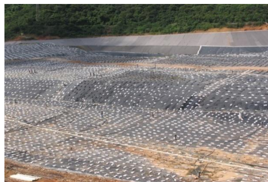
（下坪填埋场垃圾填埋区域及时覆盖图）
