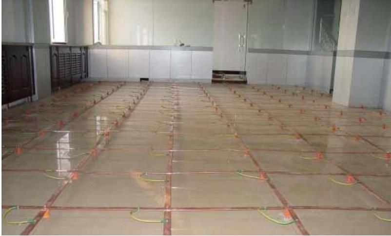
等电位连接施工示意图
