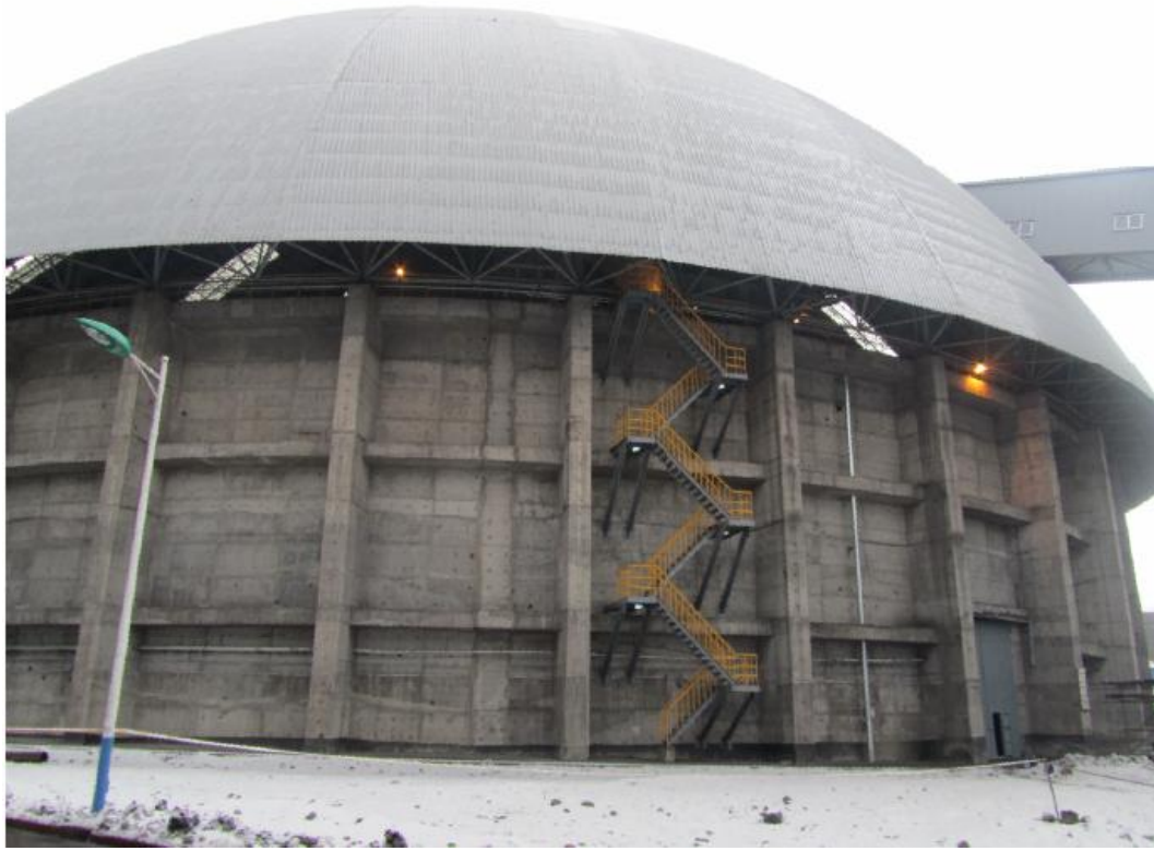
圆形煤场围护结构外立面
