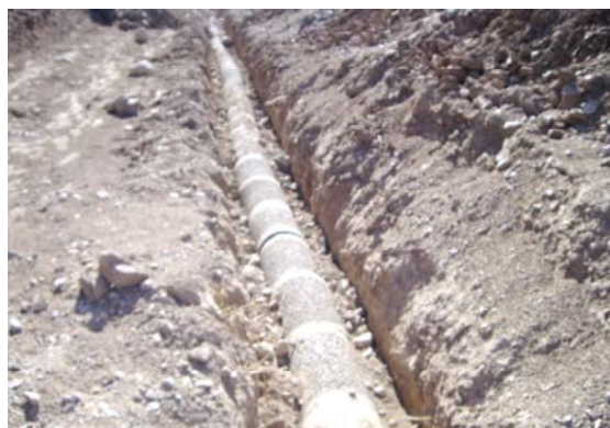
铺装排盐碱管
