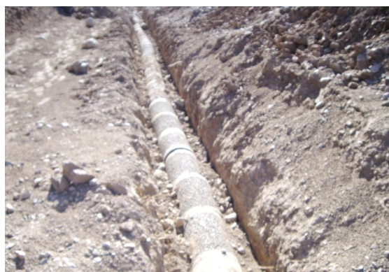
铺装排盐碱管
