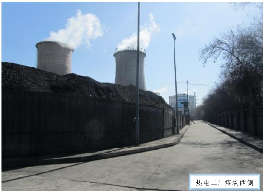
西热电二厂煤场东北侧设置有半封闭状钢筋混凝土挡墙，挡墙高不足 3.0 米，挡墙上无任何防风抑尘设施，东北侧有二厂的沉渣池等老厂的构筑物。
