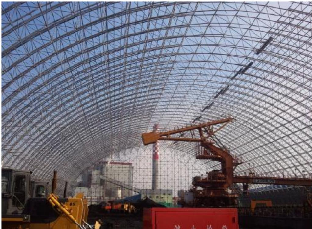
双层柱面网架结构图一
