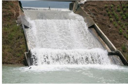
由于弃土场面积和容量有限，导致疏浚泥浆沉淀时间不足，部分泥浆会随余水排入下游水体，造成水体二次污染。浙江疏浚经过长时间的摸索与实践，成功研制了一种余水处理装置及相应工艺。该技术通过在弃土场退水口设置余水处理装置和自动控制系统，利用符合环保要求的絮凝剂，结合退水口的余水水流特点，使添加剂与余水充分混合，加快泥浆沉淀速度，确保从沉淀池二级退水口流出的余水，SS 值达到设计要求的标准，从而避免对周围水体造成二次污染。
