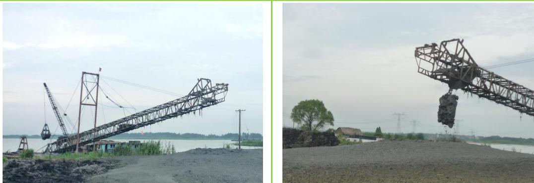
传统水利疏浚工程中，通常要求将疏浚开挖的原状土方用于加高加固岸线堤防，以实现疏浚与筑堤相结合，这样既扩大了过水断面，又提高了堤防的防洪等级。用于筑堤的水下土方，需要取用贯入击数较高的硬质原状土，以保证堤防质量。但该类土质较难开挖，若用普通机械效率较低。为提高效率，浙江疏浚研发出了相应的疏浚土方筑堤技术，该技术利用定位桩系统以及挖掘功能强的反铲抓斗，进行水下开挖，能有效克服船体常规抛锚法定位导致的容易逃锚以及施工时阻碍航道通船的弊端；该技术采用的定位系统使得定位更加牢固、精确，提高了水下开挖质量和功效，能充分适应水下硬质原状土的开挖要求。此外，该技术应
