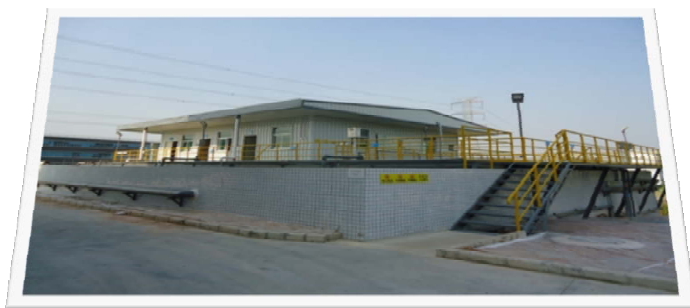
升级改造后的污水处理站
