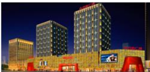
抚顺万达广场亮化工程
