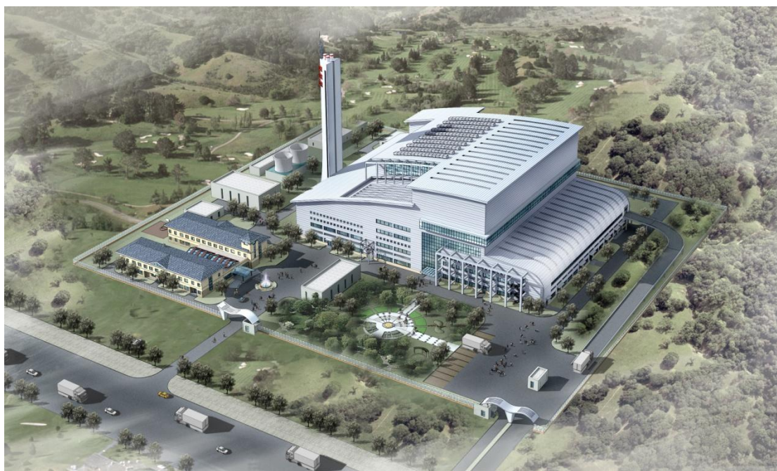
成都洛带城市生活垃圾焚烧厂建设规模设计日处理城市生活垃圾 1200 吨，年处理 40 万吨。基本技术路线采用炉排炉焚烧加烟气处理加余热发电，年发电量约 1.3 亿度。
