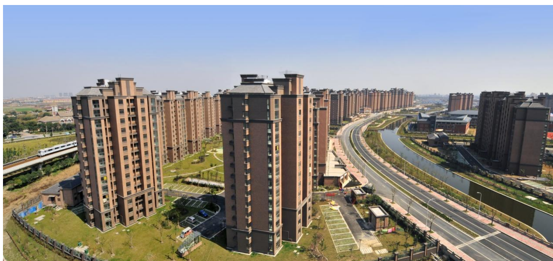
松江泗泾新凯三期保障房全景
