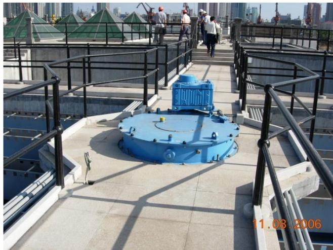
深度处理，深度处理采用臭氧—生物活性炭深度处理工艺，新系统由法国德利满公司与上海市政工程设计研究院联合进行设计，法国德利满公司提供主要工艺设备。目前工程正在进行土建施工和设备安装阶段。
