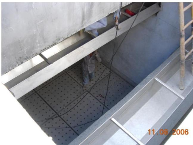
部无承托层。在活性炭的选用上，安装 3 种破碎炭进行试验，即：压块破碎炭、直接破碎炭、柱状破碎炭。活性炭层顶部距滤池反冲洗排（进）水槽堰顶高度 1.0 米。
