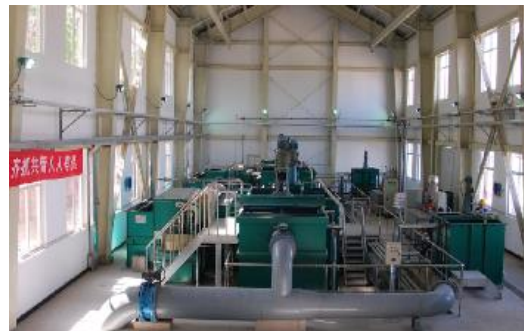
国内首个采用超磁分离技术的市政污水处理工程 —北京市北小河再生水厂二期工程一级强化系统
