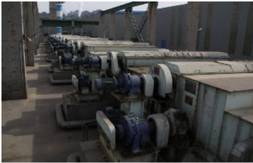
国内最大的钢厂整体搬迁工程 —首钢集团曹妃甸热轧工程水处理项目
