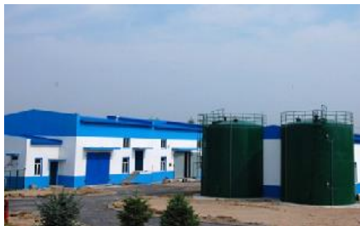
大庆油田采油回注水处理项目
