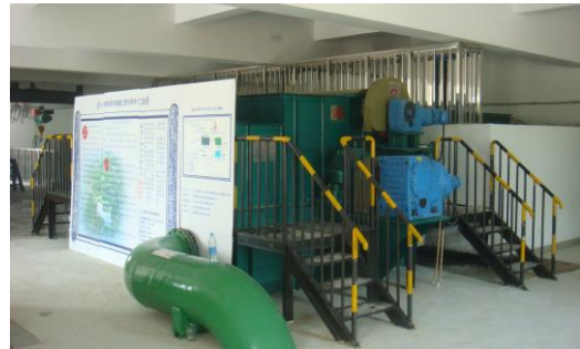
北京市大兴新城滨河森林公园（埝坛水库湖区）水环境治理项目
