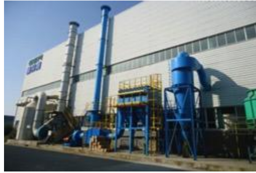
废五金拆解线废气治理系统线路板控制性破碎分选线废气治理系统
