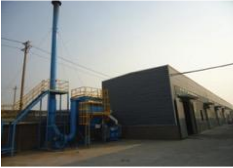
废五金拆解线废气治理系统线路板控制性破碎分选线废气治理系统
