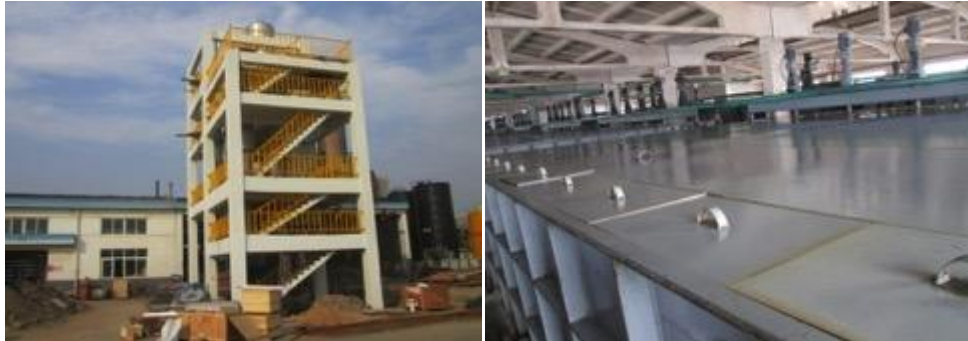
废水除盐设施工程萃取箱采用加盖密封工程
