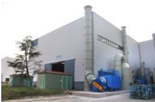
造粒废气改造后集气处理设施
