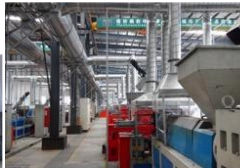
造粒废气改造后集气处理设施
