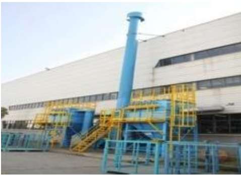
电视机粗拆岗位集尘系统和除尘设施
