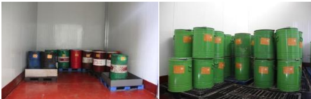
废矿物油贮存车间 荧光粉贮存车间
