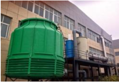
氨回收循环利用系统脱油炉水淋洗塔
