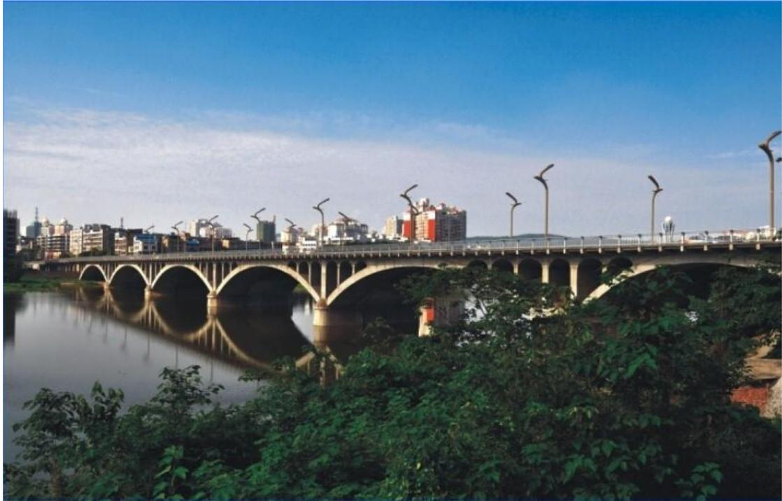
**项目简介：**绵阳南河大桥灾后加固改造工程项目位于四川省绵阳市市区安昌河，桥梁全长 412.45m，其中主桥为钢筋混凝土拱桥，引桥为简支梁桥，旧桥桥面宽度 17m，针对灾后危桥，设计对主拱及基础进行抗震性能评估，拱上结构改建为纵横梁体系，桥面外侧各加宽 2m，车行道由 2 车道改为 4 车道，荷载设计等级由原汽—20 提高到城—A 级，按现行抗震烈度标准设防。项目获 2012 年度重庆市优秀勘察设计二等奖。
