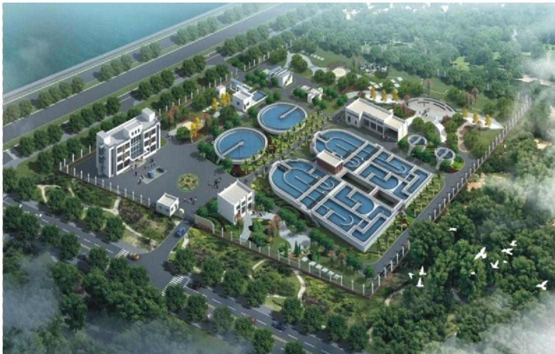
**工程简介：**本污水工程规划规模 6.0 万  $\text{m}^3/\text{d}$ ，采用改良型 Carrousel 2000 氧化沟工艺，预处理采用旋流沉砂池，消毒采用紫外线消毒工艺，污泥处理采用“撇水池+机械浓缩脱水”工艺，泥饼外运至城市垃圾焚烧厂与垃圾混合焚烧。
