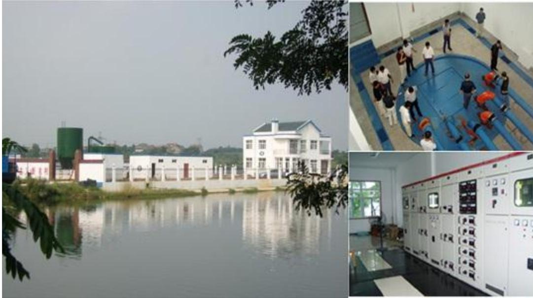
**工程简介：**该工程设计取水规模为 5 万 t/d，于 2005 年 7 月开始施工建设，2007 年 5 月竣工验收通过。该取水工程采用公司自有专利技术设计施工。工程设计荣获“2008 年度重庆市优秀工程设计一等奖”。
