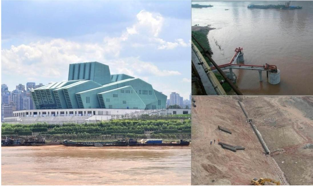
**项目简介：**整个江北城 CBD 区域规划建筑总面积超过 1000 万平方米，该区域内嘉陵江岸设置两个能源中心，对江北城 CBD 区域大剧院、科技展览馆等约 400 万平方米公共建筑实施江水源热泵集中供冷供热。两个能源中心夏季高峰时段冷却水量共需 17000m<sup>3</sup>/h，需水量巨大，在嘉陵江取水成为项目关键设计，公司承担该项目取水工程设计，采用地表取水和渗渠取水相结合的综合取水方式获得成功。该项目荣获“2008 年重庆市优秀工程设计二等奖”。
