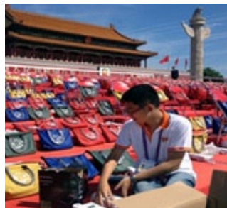
在观礼台安装固定电话和宽带网络
