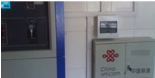
企业前端污染源数据监测小屋
