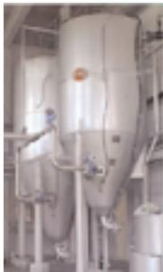
KWI的“Klaricell”一体化澄清池，可将各传统处理工艺集成于一体，适合于市政和工业给水处理。该工艺尤其适合于含藻类或其他物质的高悬浮物地表水作为原水的处理流程。该一体化澄清池，集气浮、澄清和双介质过滤器为一体，是一种高效经济可靠的处理方法。
