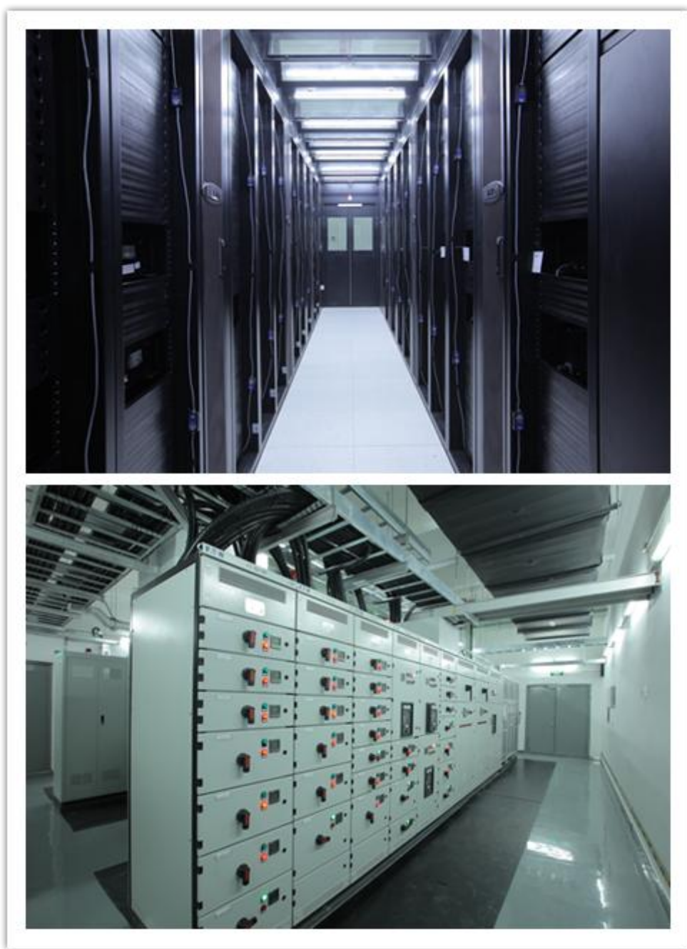
图 8：9 号数据中心机房
