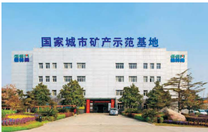
◀ 荆门格林美国家城市矿产示范基地
