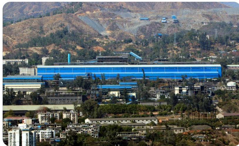
矿业公司选矿厂闭路除尘改造噪声治理
