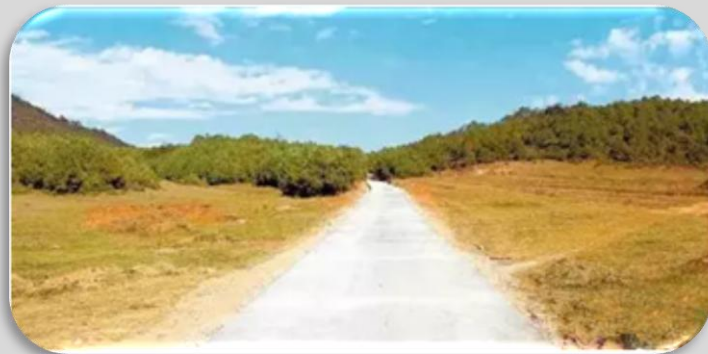
竣工后的盐宁路
