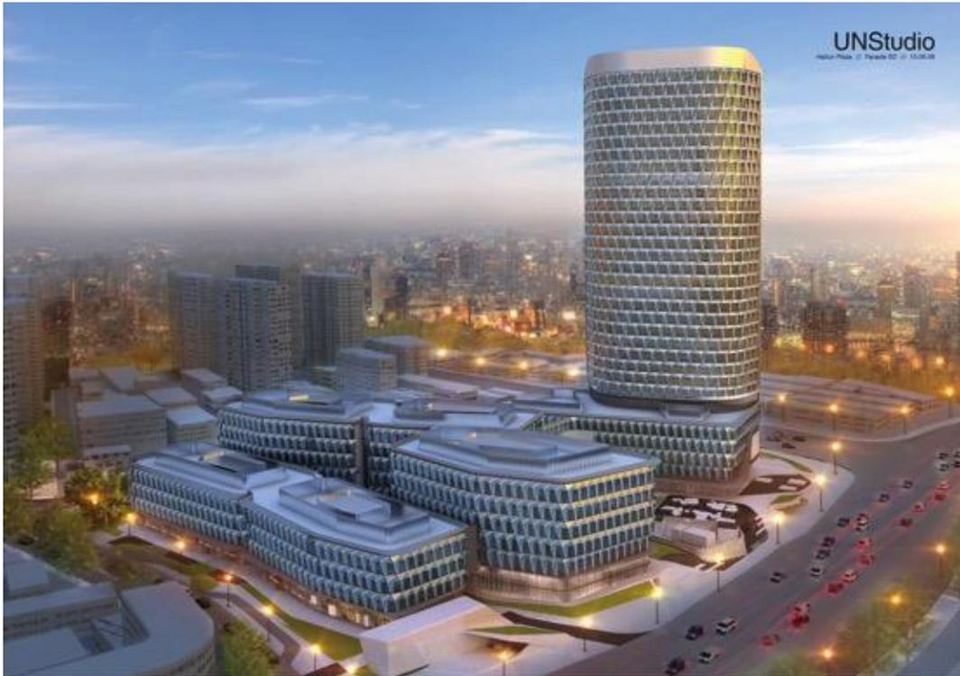
金融街（海伦）中心按照 LEED 金级和绿色二星建筑双认证标准打造，并已获得美国绿色建筑委员会 LEED 金级预认证，可有效降低能量消耗，减少企业运营成本，带来更舒适、更健康的办公环境。项目采用国际领先的三银 LOW-E 玻璃幕墙，不仅同比普通玻璃节能水平提高 80% 以上，更营造生态舒适的办公环境；采用节水型洁具，同时回收中水，用于绿色灌溉，道路冲洗，车库冲洗；采用 MERV13 级别的高效过滤器，高效去除室外大气中的 PM2.5。屋顶绿化面积占可绿化面积的 50%，减少顶层空调费用和屋顶热岛效应，节能达到 12%；采用人车分流设计，预留 10% 电动车位，为绿色电动能源汽车提供充足车位，倡导低碳出行，引入车库道闸自动感应系统，可有效节约停车入库时间。
