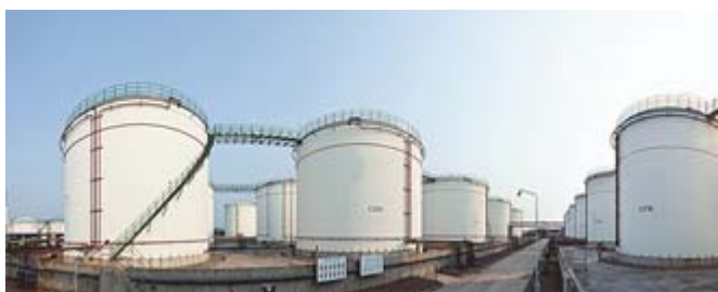
聚酯油品储罐
