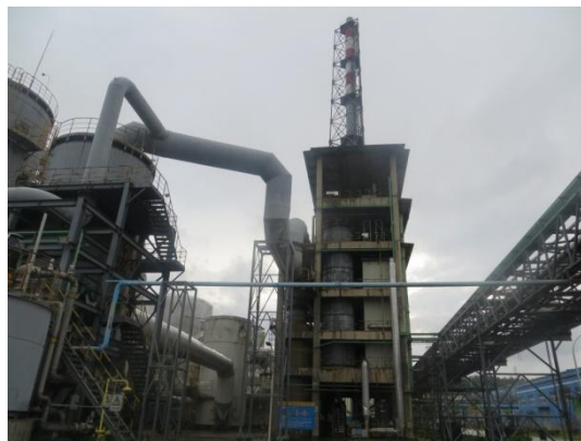
紫金铜业硫酸尾气脱硫设施
