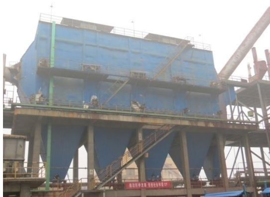
洛宁紫金黄金冶炼公司除尘器
