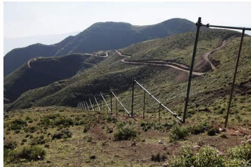
东川管道运输现场 2
