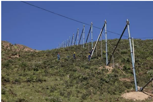
东川管道运输现场 1
