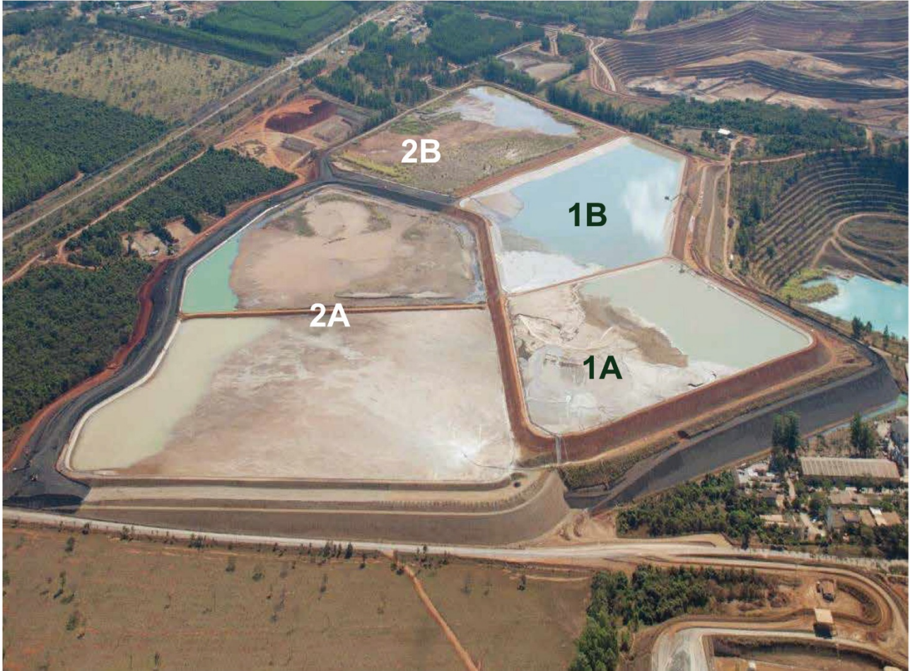
图 0-2 铌尾矿储存设施全景图
