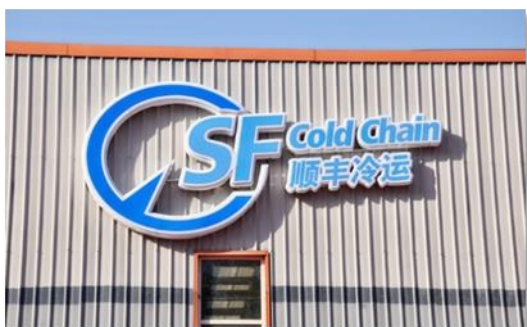
图6.36 顺丰控股冷库外观
