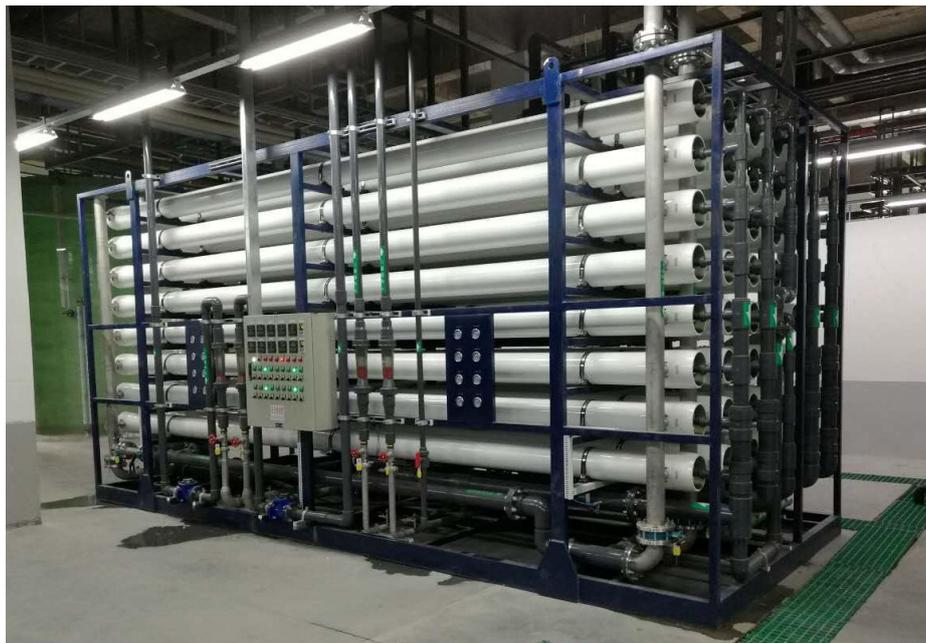
反渗透膜系统是一次性去除原水中 98% 以上离子、有机物及 100% 微生物（理论上）最经济高效的纯化方法。CDI 装置应用电再生离子交换除盐工艺取代传统混合离子交换除盐工艺，通过离子交换树脂及选择性离子膜达到连续稳定的深度脱盐效果，可使产水水质达到  $17\text{M}\Omega \cdot \text{cm}$  以上。超纯水后处理系统通过除 TOC 机、抛光树脂床及终端过滤器，进一步去除超纯水中尚存的微量离子、有机物及颗粒等杂质，以满足不同用途的最终水质指标要求。
