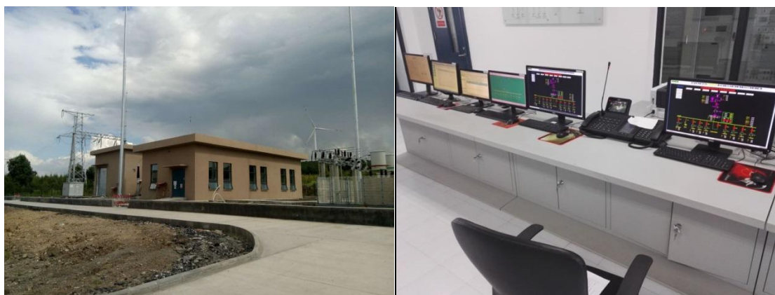
风电场共用升压站
