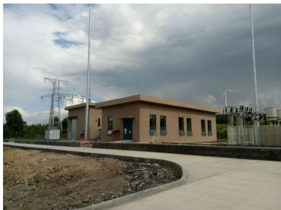
风电场共用升压站
