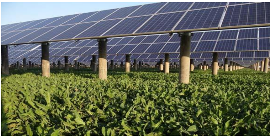
预应力管桩高支架下的农作物
