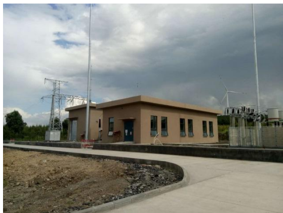
风电场共用升压站
