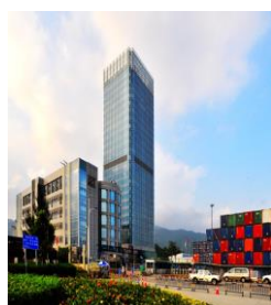
和记黄埔 深圳总部大楼
