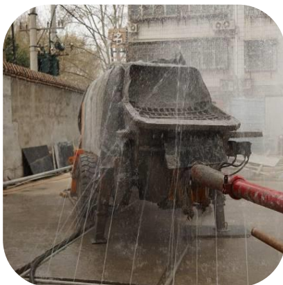
5. 施工区域安装工程洗车机
