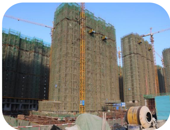
棚改一期工程兰高庄安置区顶板支模
