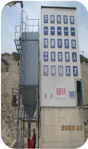
1. 砂石系统施工生产过程中采用除尘设备降尘
