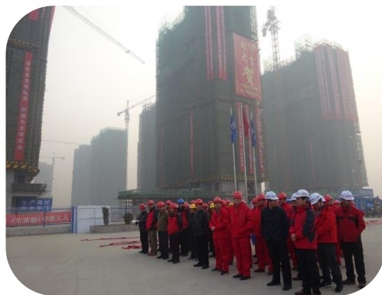
棚改一期工程兰高庄安置区主体全部封顶
