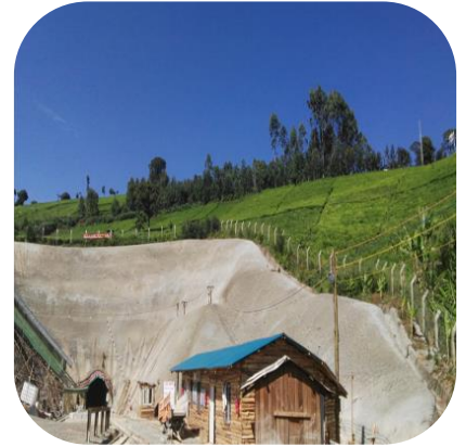
7. 肯尼亚项目部对施工红线内用地安装防护围栏
