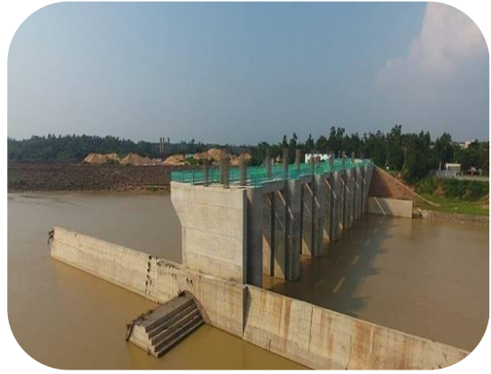
已建成引水工程主体大坝
