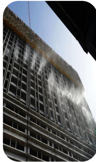
3. 施工现场安装喷淋设施
