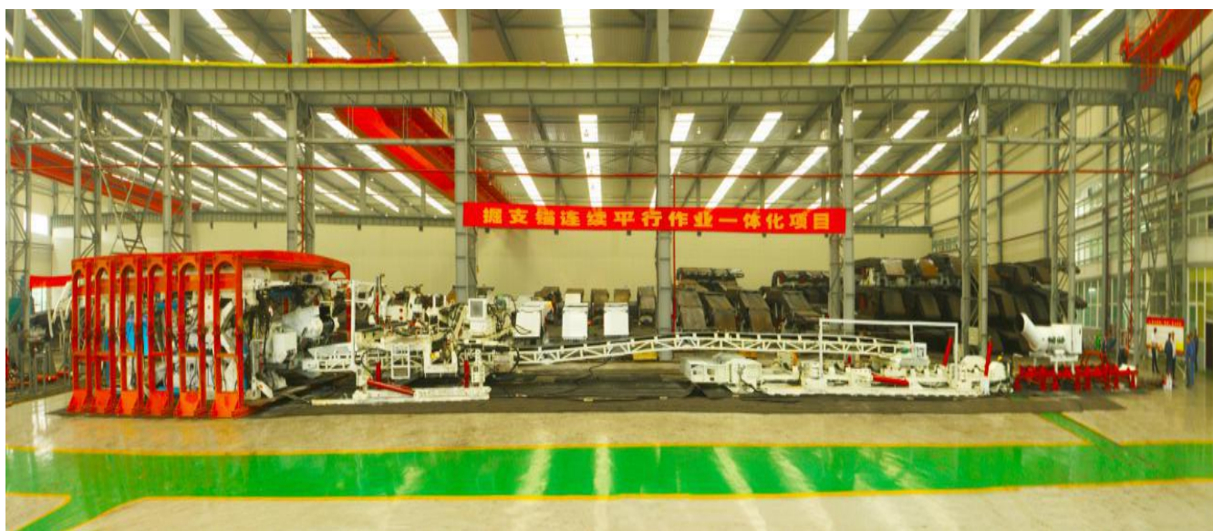
漳村煤矿掘支锚连续平行作业一体化技术达到国际领先水平
