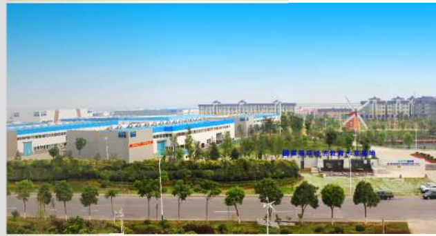
01 格林美（荆门）循环产业园 GEM(Jingmen) Recycling Industrial Park
