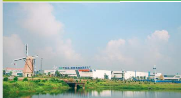
03 格林美（江西）循环产业园 GEM(Jiangxi) Recycling Industrial Park
