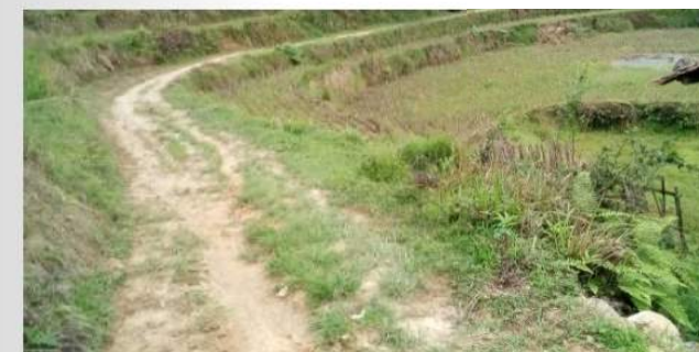
小坑村黄洞组通组公路（修路前）
