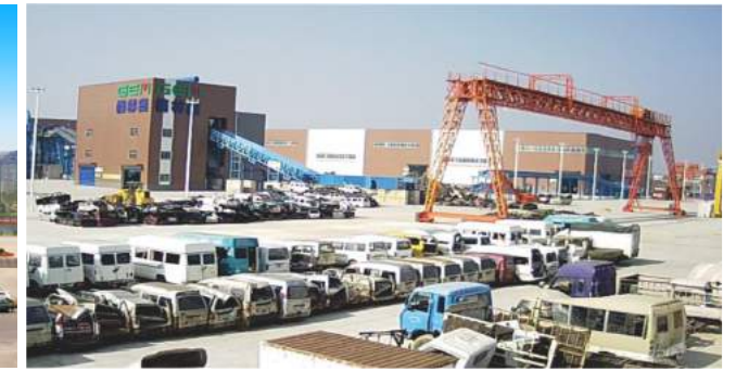
02 格林美（武汉）循环产业园 GEM(Wuhan) Recycling Industrial Park
