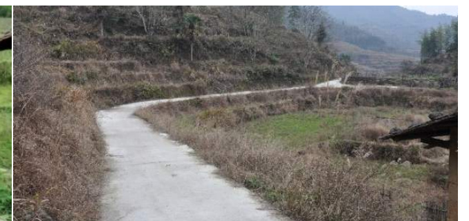
小坑村黄洞组通组公路（修路后）
