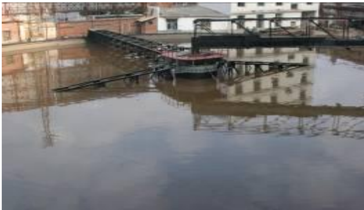
尾矿回水设施
