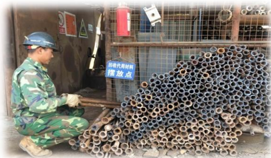
自制吊筋锚杆
