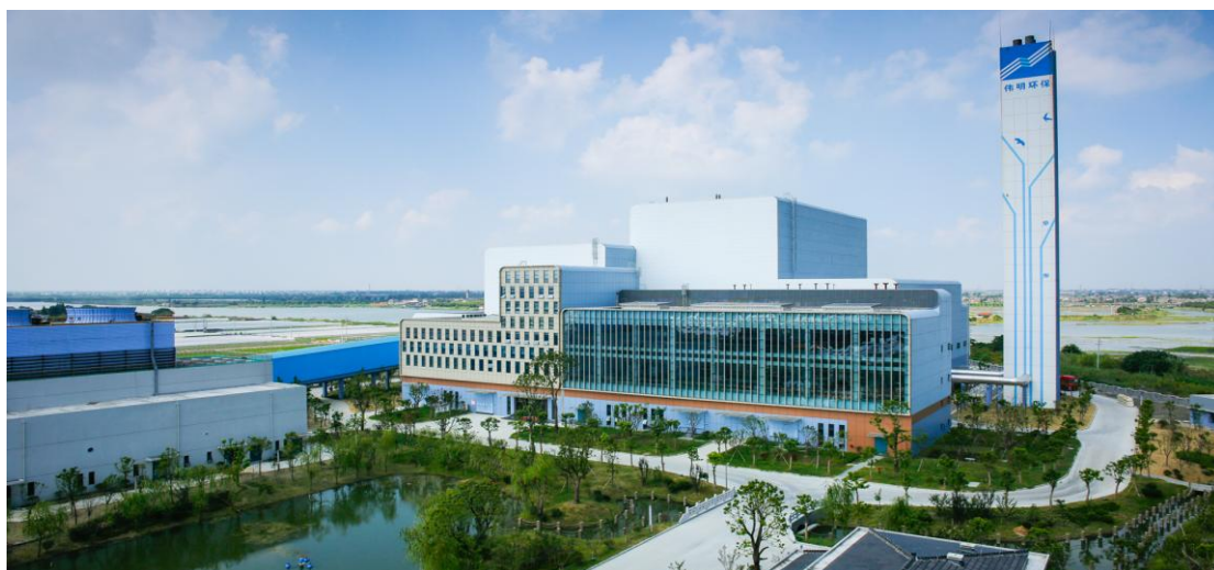
图一：嘉善垃圾焚烧发电厂
