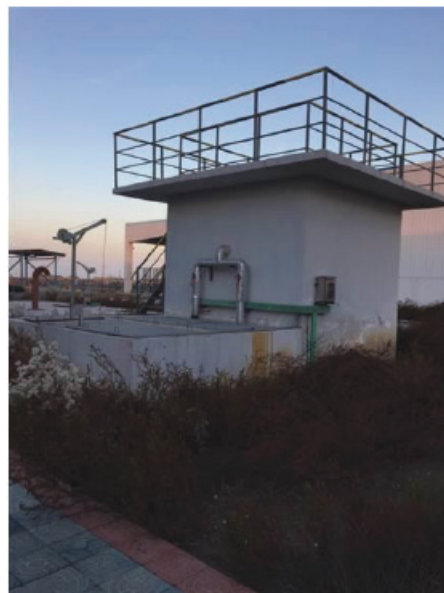
污水站—污泥槽
