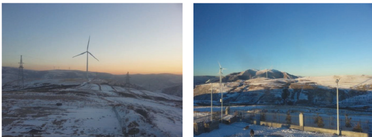
圖7.1寧武風電風力發電機組
