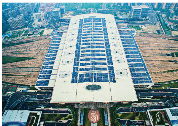
杭州东枢纽太阳能光伏屋顶项目
