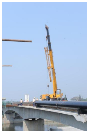
供水管网建设
