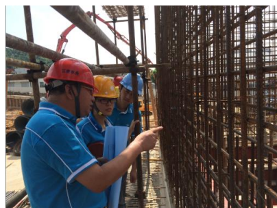
小湾水厂深度处理改造工程
