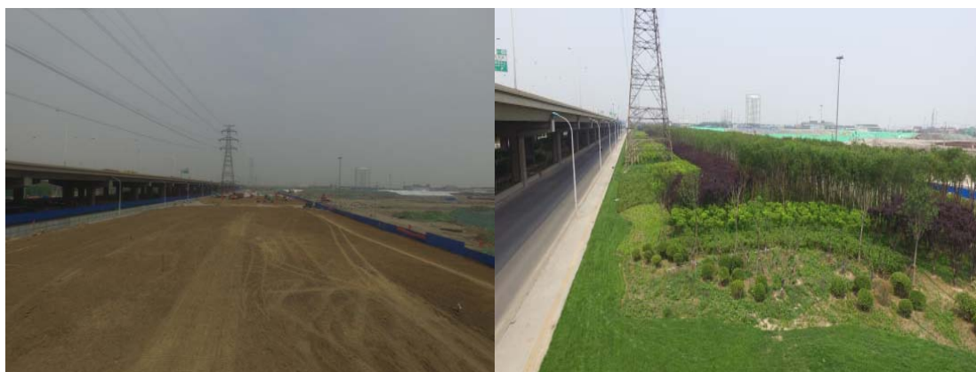
盐碱地修复：海港公园周边市政配套工程（排水明渠改暗涵工程和配套绿化工程）（修复前、后）
