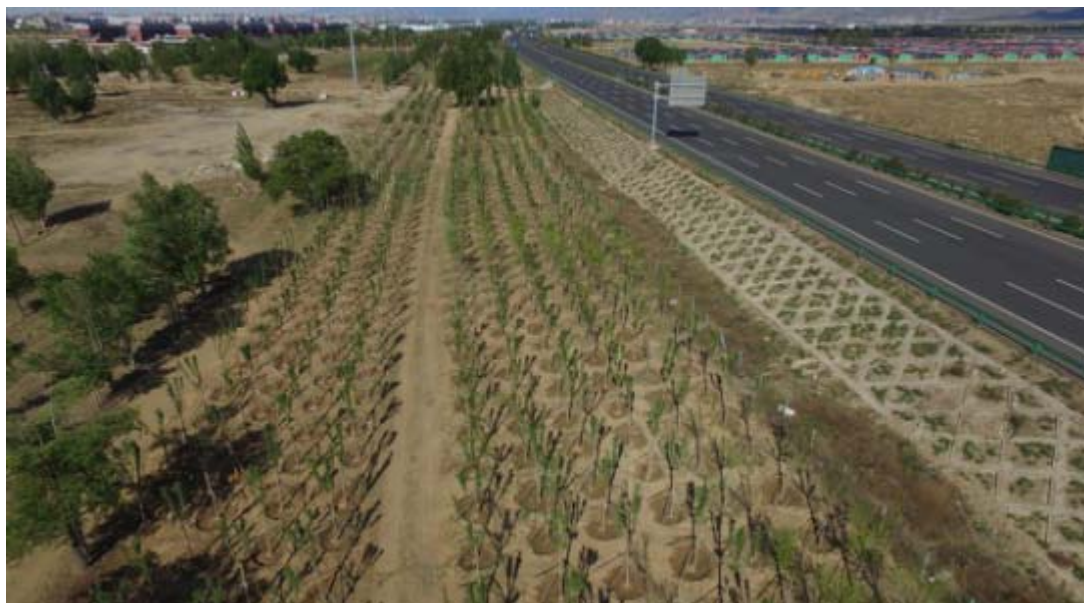
高速两侧边坡修复：呼市园林局2014年第一批园林绿化工程-京藏高速两侧绿化工程
