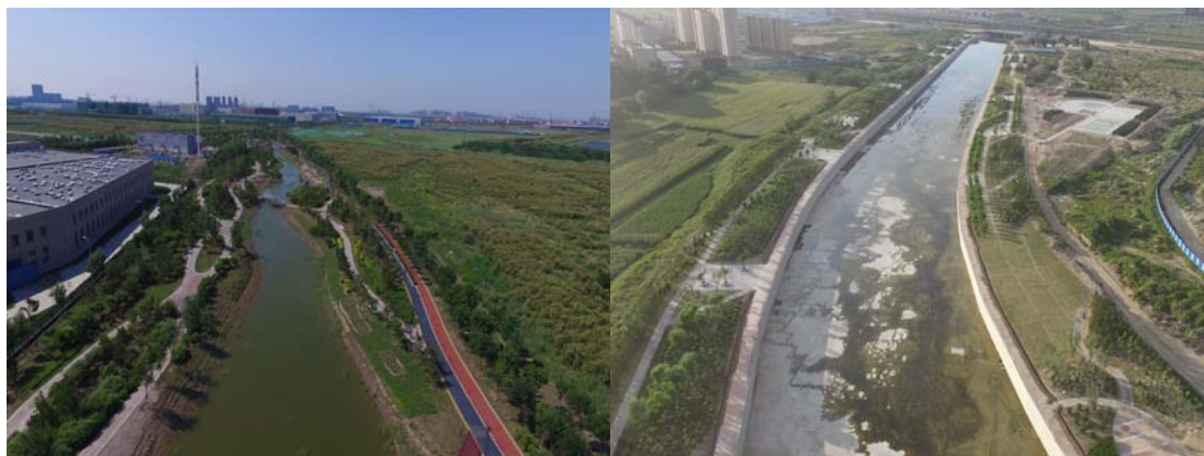
河道治理：滨海科技园2014年河道景观工程项目二标段、九原区四道沙河景观带工程项目施工
