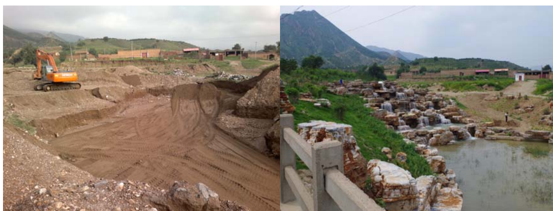
生态保护区恢复：乌素图召文化保护区景观建设项目（一期）工程（修复前、后）
