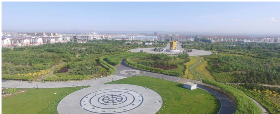
生态保护区恢复：丰镇市黑河城区段环境治理工程施工
