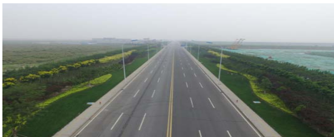
盐碱地修复：天津临港工业区三期基础设施工程项目-渤海十八路（长江道-珠江道）道路绿化工程
