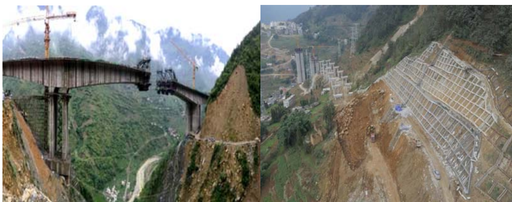
云南麻柳湾至昭通高速公路： 在复杂地形地质条件下的公路选线、碎石土地区公路支挡结构物、大型滑坡体治理、大跨径高墩桥梁、高地震烈度区结构安全性、岩堆地区隧道修建技术、路域生态环境等山区公路修建的技术难题上取得了突破。
