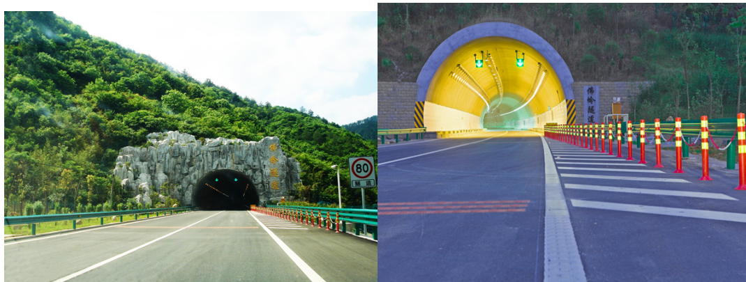
佛岭隧道： 具有完善的通风、照明、消防、供配电、监控及中央控制管理系统。获中国勘察学会 2012 年度公路交通优秀设计二等奖。
