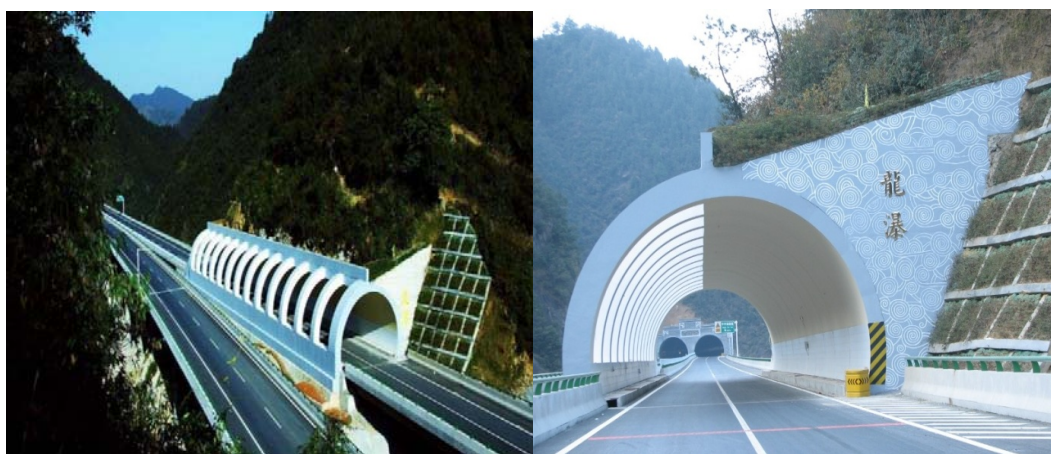
龙瀑隧道： 国内首座半明半暗的通透肋式拱梁异型结构隧道。荣获安徽省公路学会科技进步一等奖、中国公路学会科学技术二等奖。
