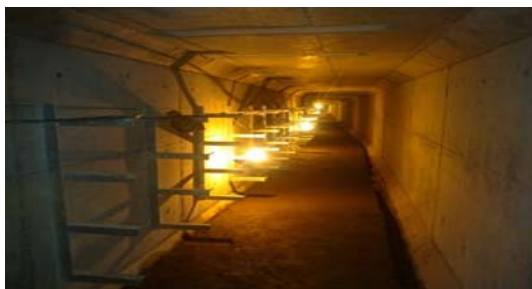
金寨现代产业园区综合管廊工程： 箱涵结构，入仓管线有给水管、电缆、弱电电缆，实现城市道路地下空间有效利用和管线管理的整合。
